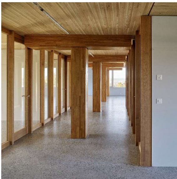
Abbildung 10: Mit Brettschichtholz aus Eiche lassen sich Bauteile mit hohen Festigkeiten und optischer Qualität erzeugen, die der Holzbauarchitektur neue Konstruktionsweisen ermöglichen. Das Bild zeigt die Innenräume des Landwirtschaftlichen Fachstellenhauses Arenenberg in Thurgau, Schweiz, mit freiliegenden Stütz- und Tragkonstruktionen. (Foto: Roland Bernath, Grupo Gámiz) Figure 10: Glued laminated timber from Oak is an attractive building product with high mechanical properties. The products offer architects new ways in wood buildings constructions. The photo shows the visible constructions of the agricultural education center Arenenberg in Thurgau, Switzerland. (Photo: Roland Bernath, Grupo Gámiz)
